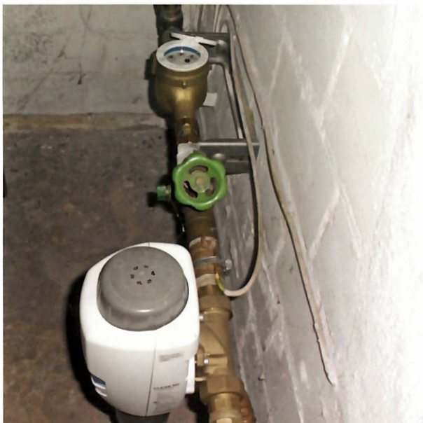
Der Filter befindet sich hinter dem Wasserzähler und hinter dem Hauptabsperrentil. Foto: Stadtwerke Böhmetal GmbH
